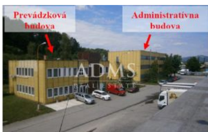
Pohľad JV strana – prevádz. a admin. budova
