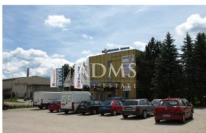
Pohľad SZ strana – administratívna budova
