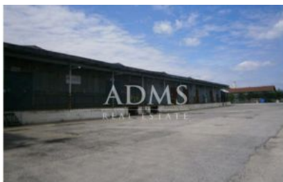
Pohľad V strana - sklad
