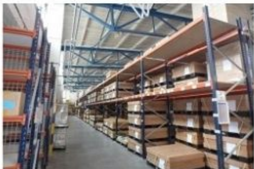
Konštrukčné riešenie halovej časti objektu – montovaný regálový systém
