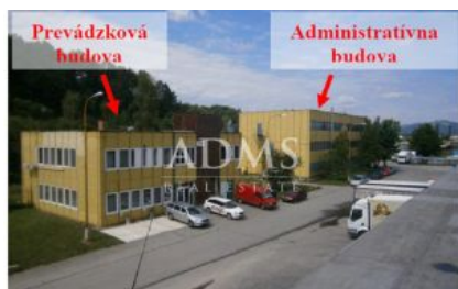
Pohľad JV strana – prevádz. a admin. budova
